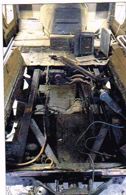
Ook de vloer en het chassis vragen veel aandacht
