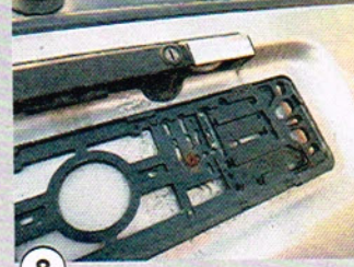
8 Unbedenklich aber hässlich: Beim Kombi korrodiert die Heckklappe aus Alu an diversen Stellen.
