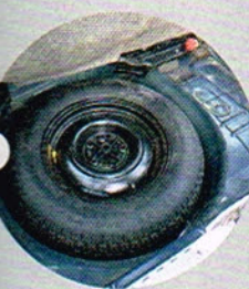
Die Reserveradmulde ist rostresistent, Unfallschäden und Wassereinträge kommen vor. Das Schnittbild zeigt einen technisch identischen Volvo 740
