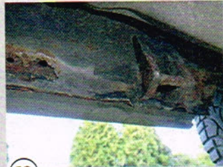
12 Die Bereiche rund um die Wagenheberaufnahmen sind häufiger Brutstätten von Korrosion
