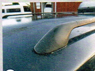
2 Durch Schmutz und Nässe kann es unter den Auflagen der Dachreling rosten
