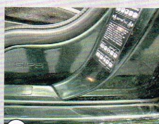
4 Egal wie interessant das Objekt der Begierde auch ist, wuchert hier der Rost unter der Abdeckung hervor, sollte man gehen
